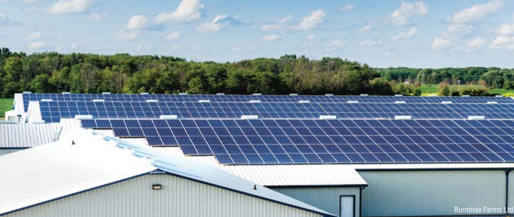
Panneaux solaires sur le toit d'un poulailler
